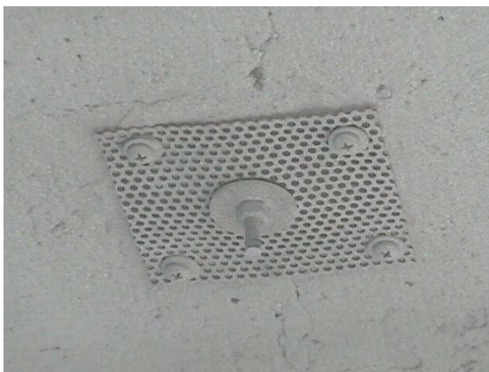
Detalle de conexión del ánodo
